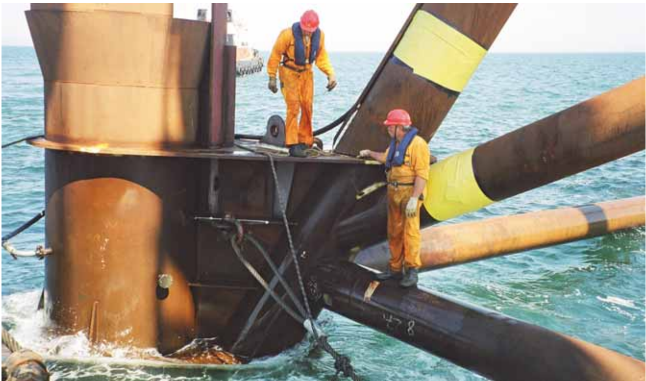
Rohrknoten der Forschungsplattform „Fino“
