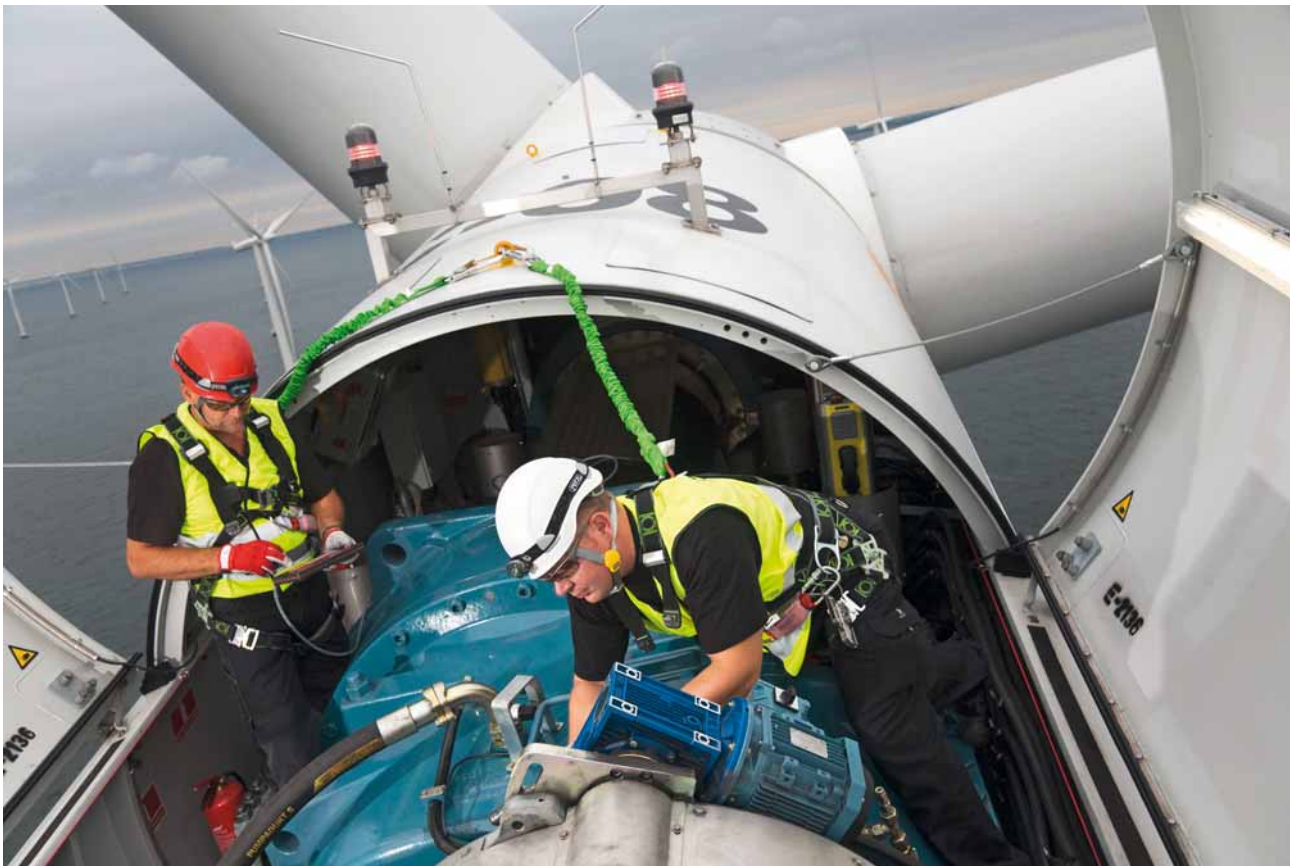
Servicearbeiten in der offenen Gondel einer Windturbine
