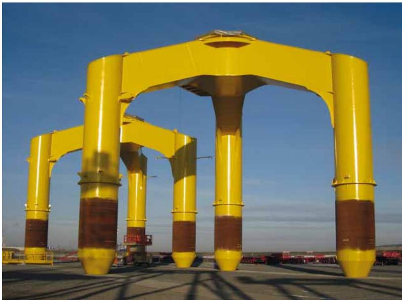
Fundament für eine Offshore-Anlage
