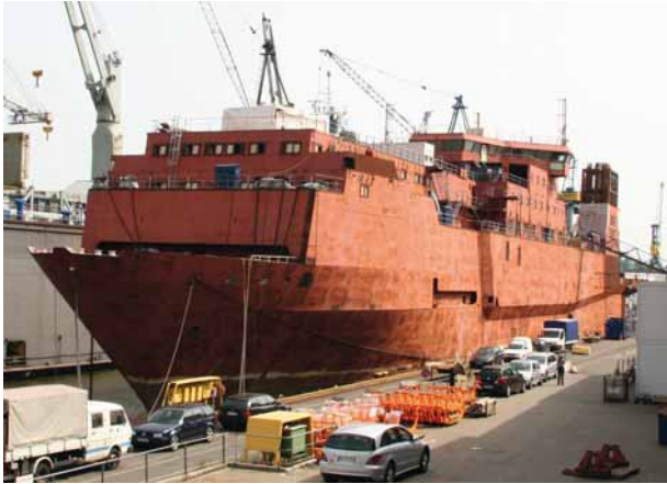
Umbau eines Kabellegers zum Offshore-Versorger
