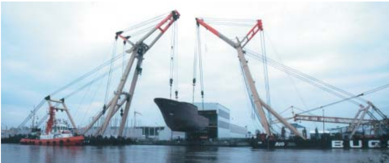
280-t-Stahlkasko für eine Yacht vor der Wasserung
