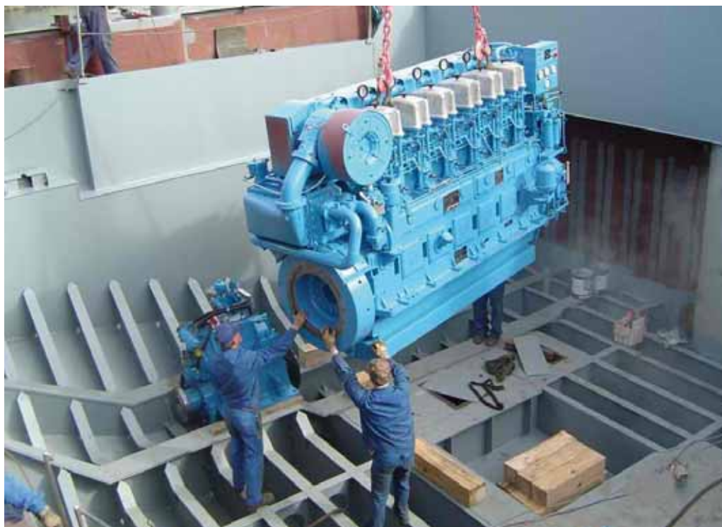
Einkranen eines schadstoffarmen Dieselmotors
