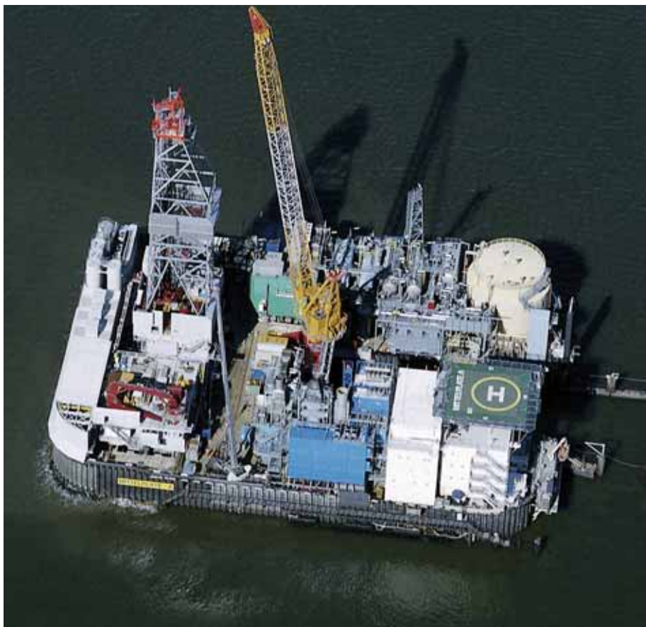
Bohr- und Förderplattform „Mittelplate“ mit Bohrturm
