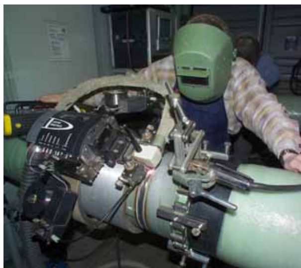
Schweißarbeiten an einer Pipeline
