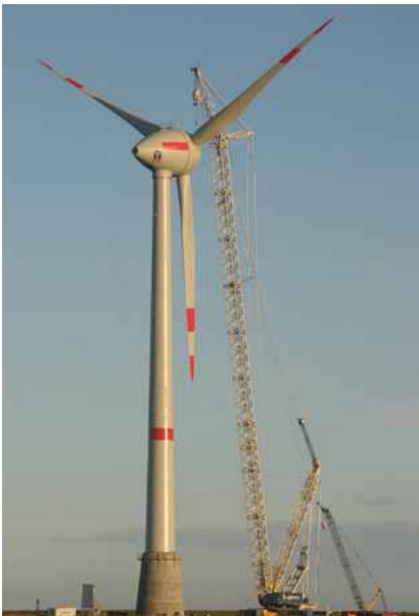
Testfeld für Offshore-Windanlagen in Cuxhaven
