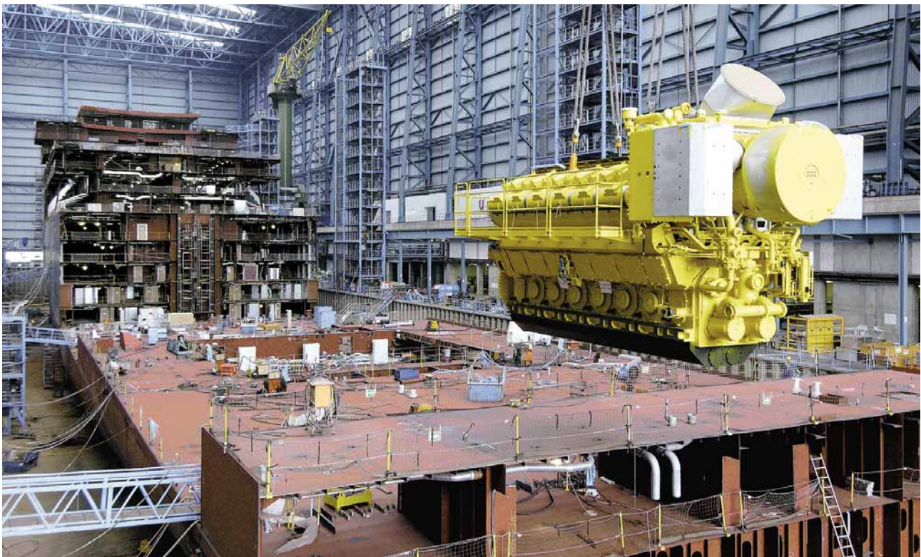
Motoreinbau beim Kreuzfahrtschiff „Norwegian Pearl“
